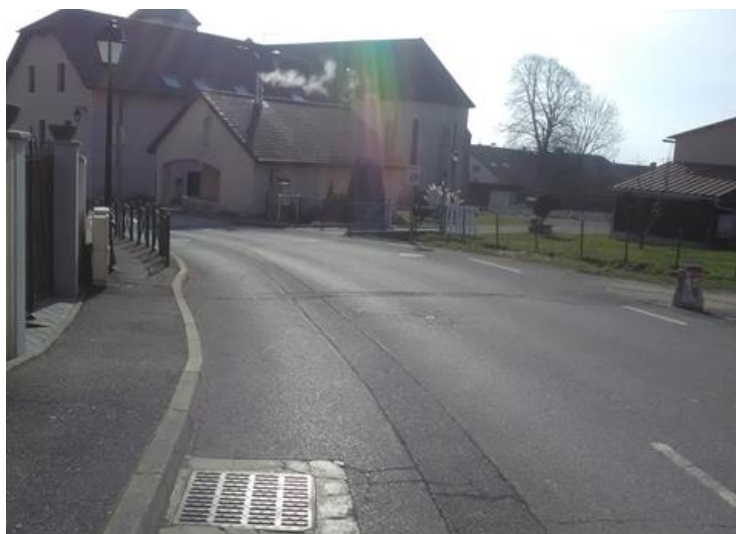
Grille d'eau pluviale Grand'rue à Péron raccordée au ruisseau.
